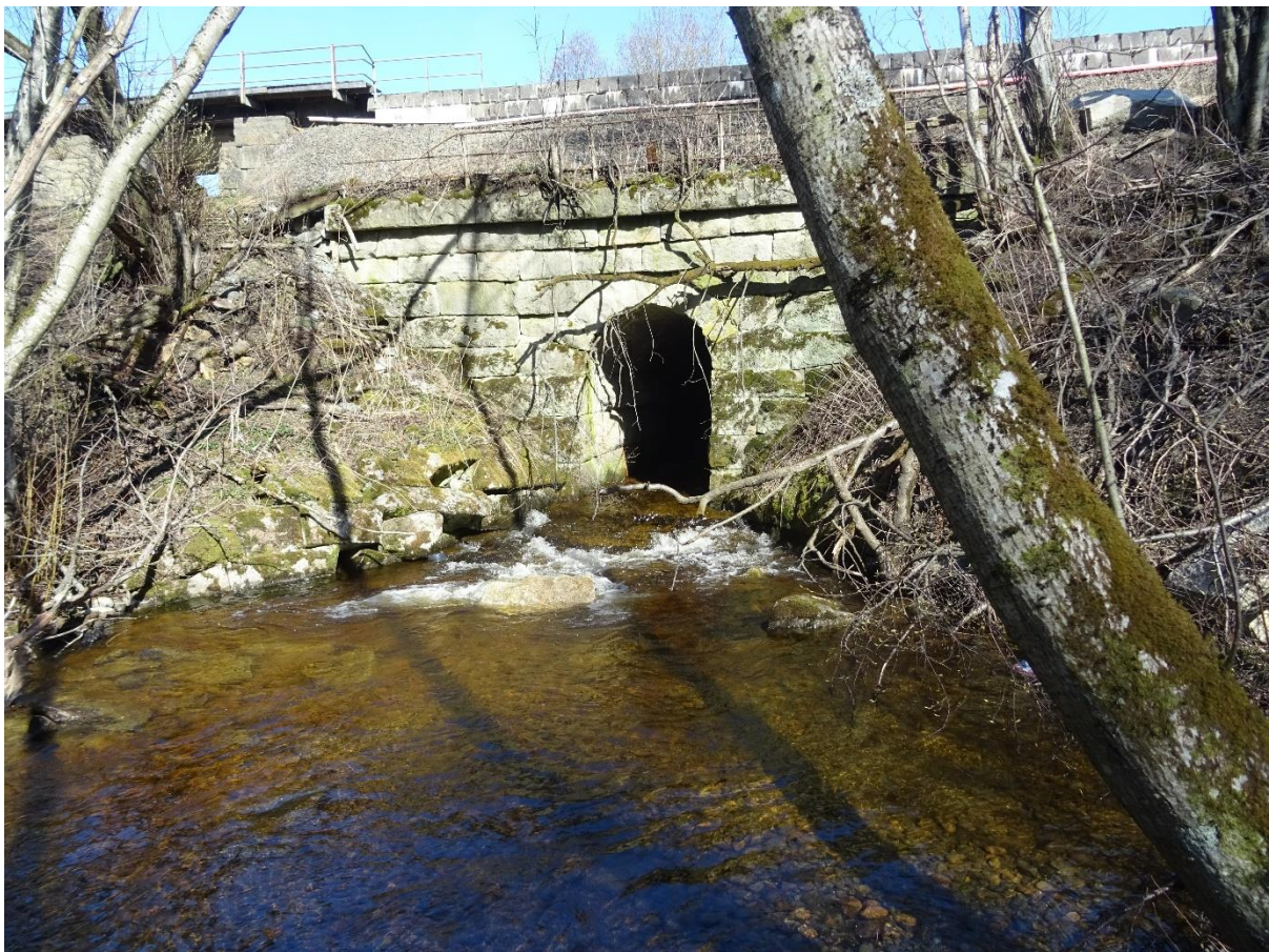
Bilde 2: Utløp fra kulvert under jernbanen
