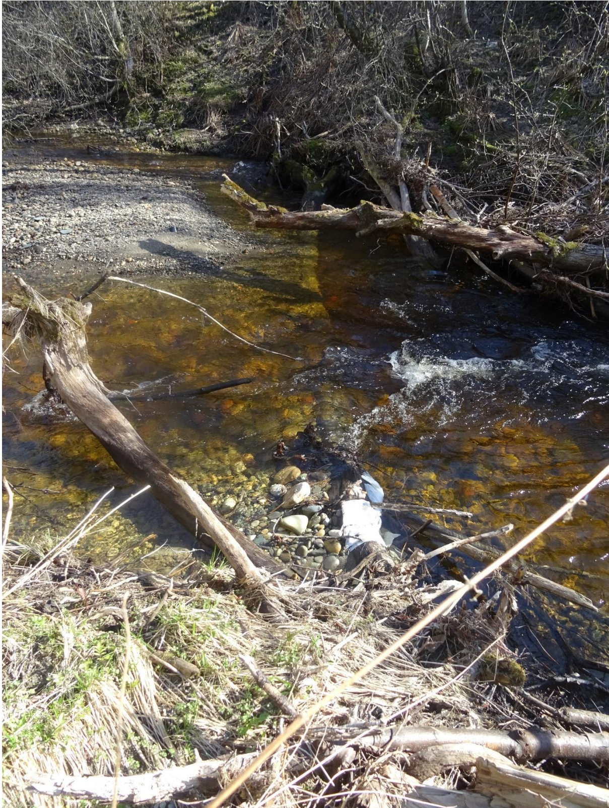
Bilde 7: Terskel anlagt av tre som har fallt. Antas litt erosjon under røtter/treverk på søndre bekkekant
