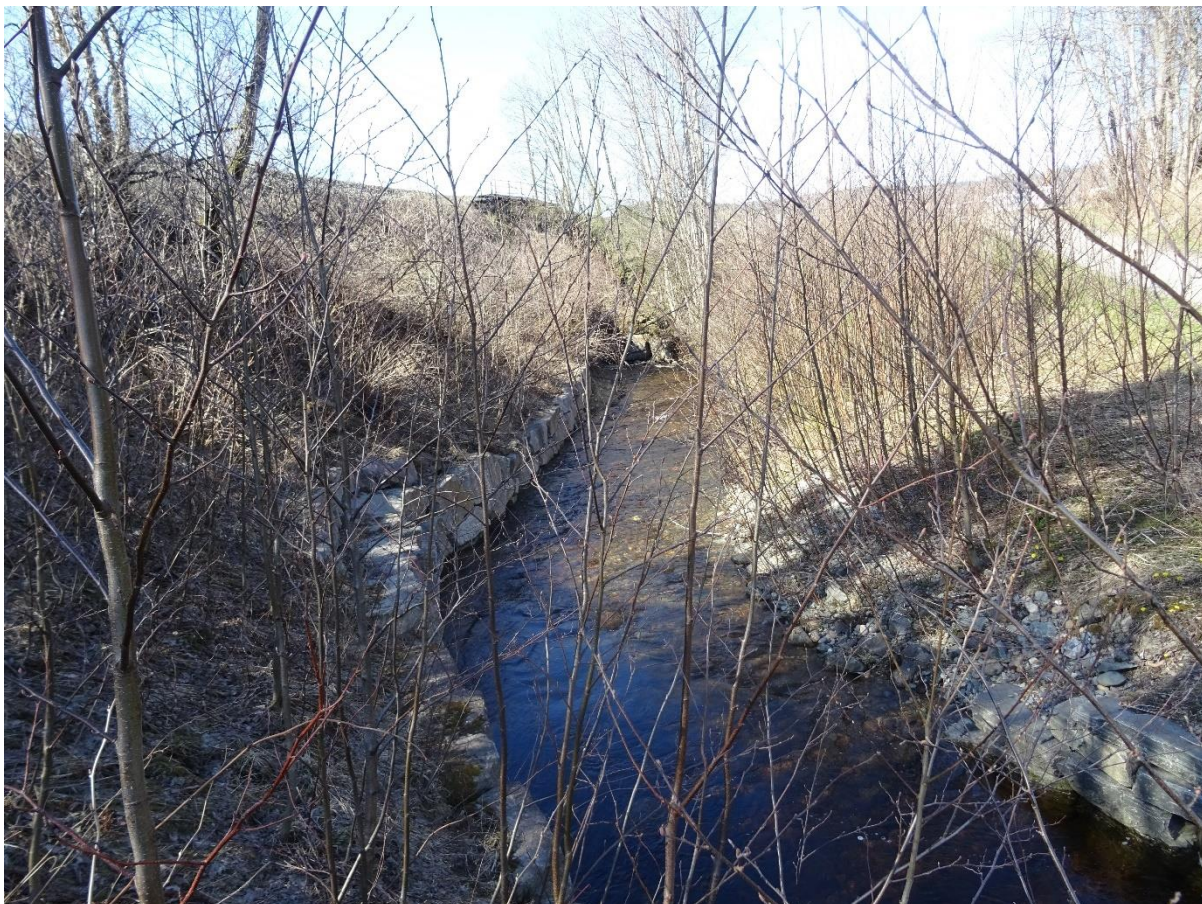
Bilde 13: Oppstrøms Loddbekken er bekkesidene erosjonssikret. Innløp til kulvert under jernbanen til venstre i enden av bekken
