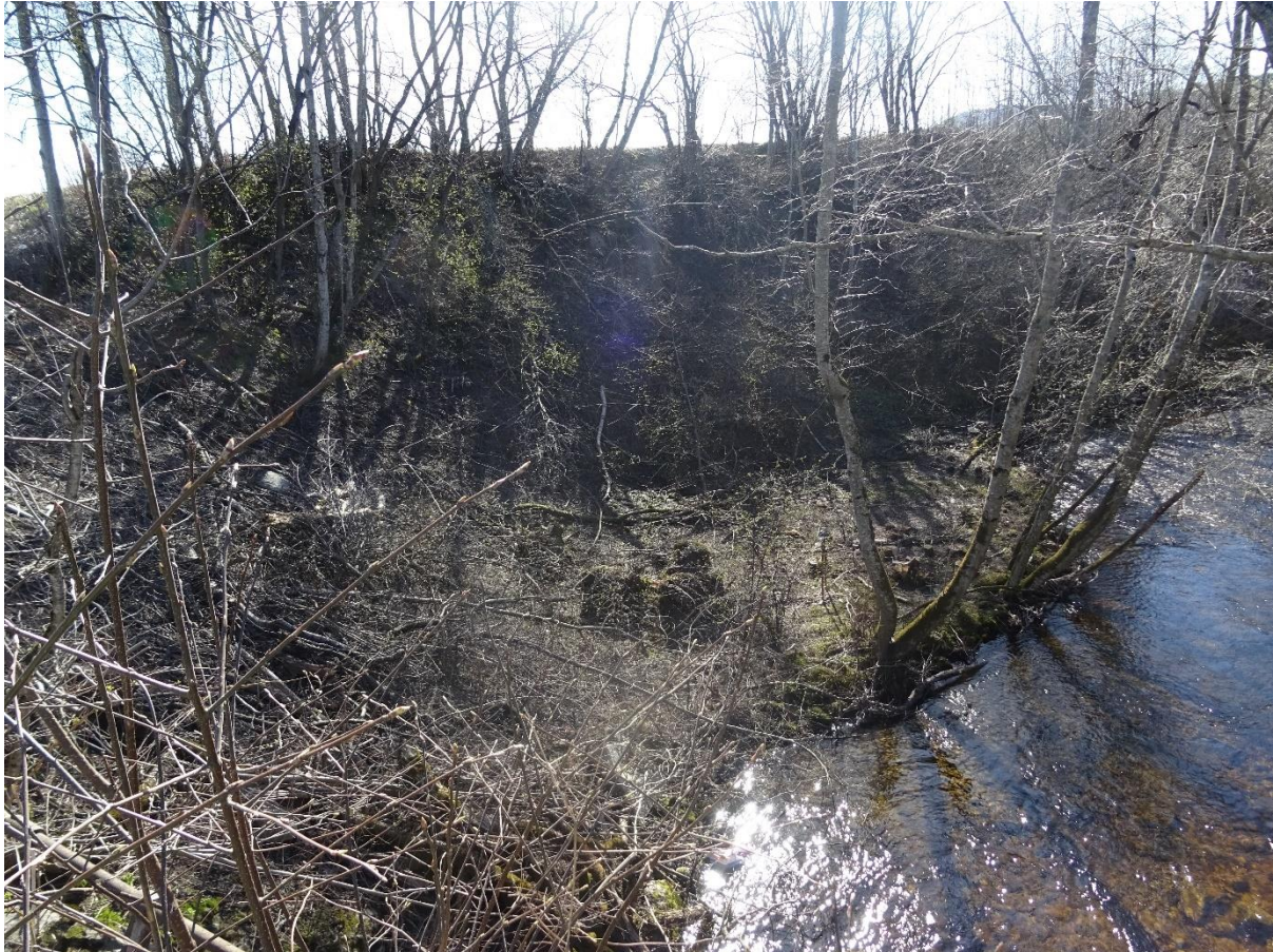
Bilde 1: Bilde tatt fra over utløpet av kulvert nedstrøms jernbanen og viser "platå" hvor BP122 er utført
